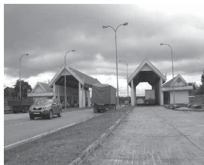
写真 25km 地点にある通関施設
