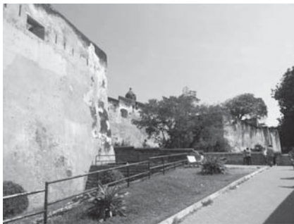
フォートジーザスの外観
